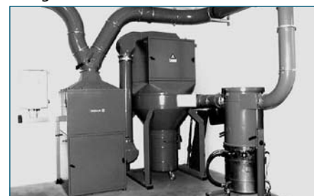
Absauganlage für Schleifstäube Extraction system for wheel dust Installation d'aspiration pour la poussière de meulage
